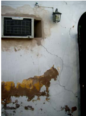
Paredes de adobe
