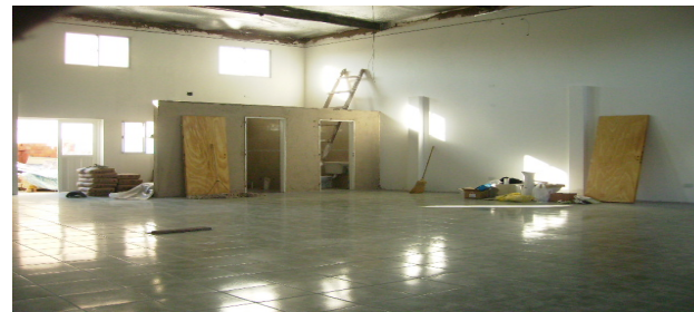
Vista actual de la obra
